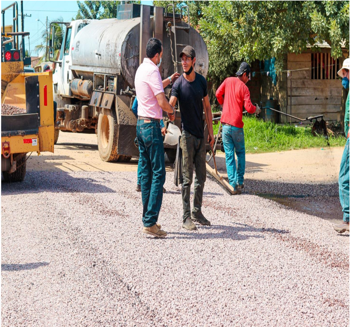
FIGURA 2 MANTENIMIENTO Y APERTURAS DE NUEVAS VIAS
