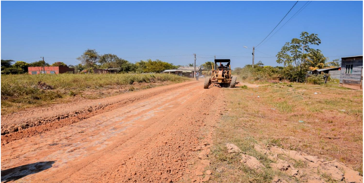
FIGURA 3 MANTENIMIENTO Y APERTURAS DE NUEVAS VIAS TIERRA Y RIPIO
