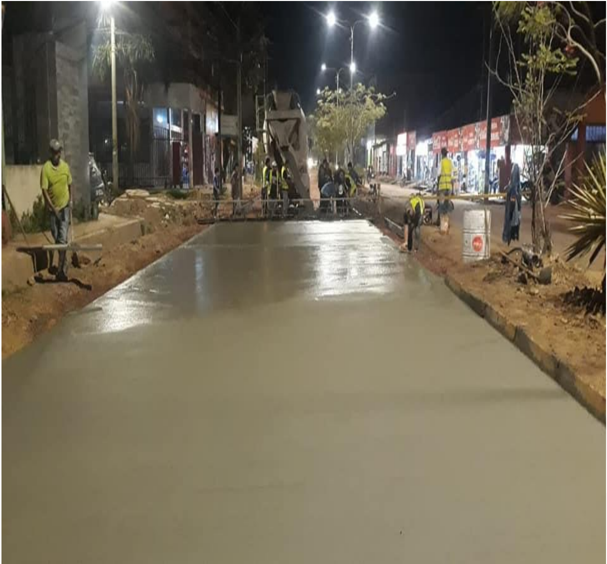
FIGURA 1 CALLES CON PAVIMENTO RÍGIDO
